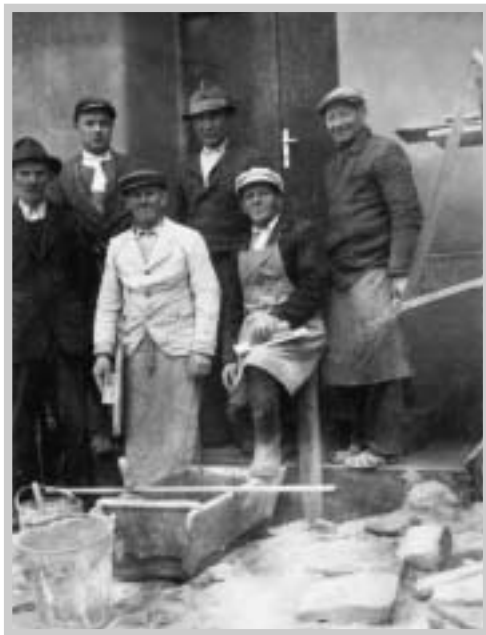
Snímek z opravy školní budovy v Pavlově srpen 1947 1. řada zleva: Antonín Hromádka, ?, Josef Krška, ? 2. řada zleva: Alois Bednář, Josef Štach
